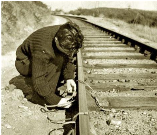
Partigiano in azione di sabotaggio su linea ferroviaria (Foto in Fondazione FS Italiane)
