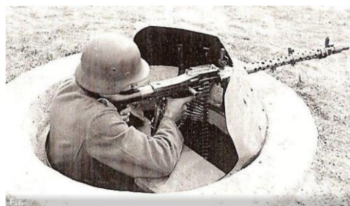
Vallo Veneto - Bunker per mitragliatrice MG in loc. Siron a Villaga e in progetto (Foto: copie in Archivio CSSAU)
