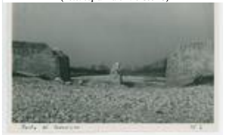
Ponte di Novoledo dopo il sabotaggio (Foto: copia in archivio CSSAU)
