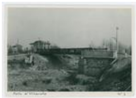
Il Ponte Rosso di Villaverla dopo il sabotaggio, ma già con ponte provvisorio in ferro. (Foto: copia in archivio CSSAU)
