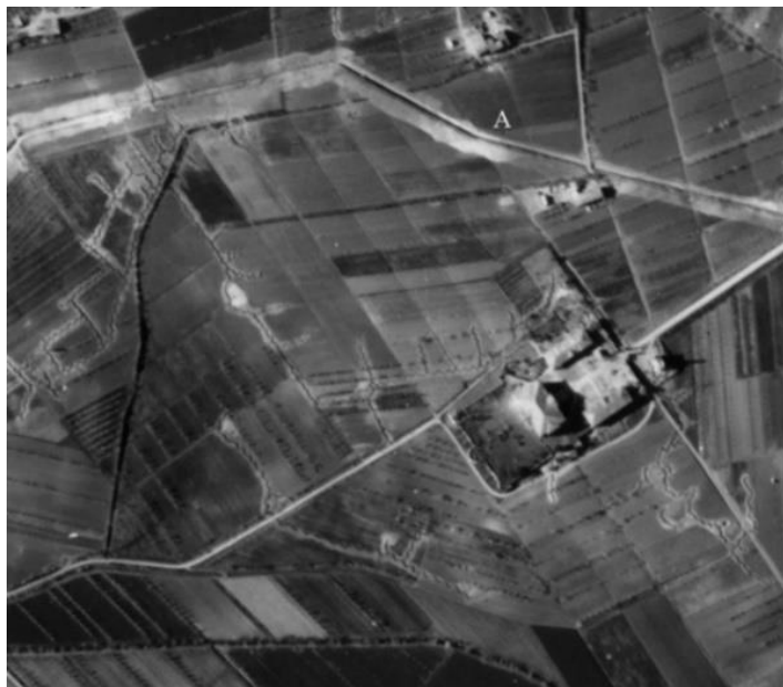
1945 - Foto aerea di Villa Favorita a Monticello di Fara: le trincee, le fortificazioni e il fossato anticarro (A) (Foto: Archivio Paolo Savegnago)
