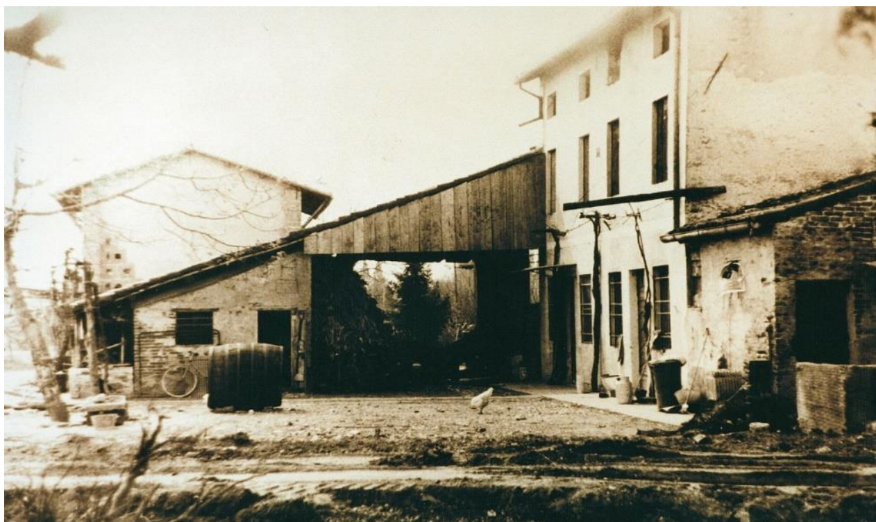
Dueville 1976 - Casa Fiorentin in via Garibaldi, demolita per costruire l'incrocio con viale della Repubblica
